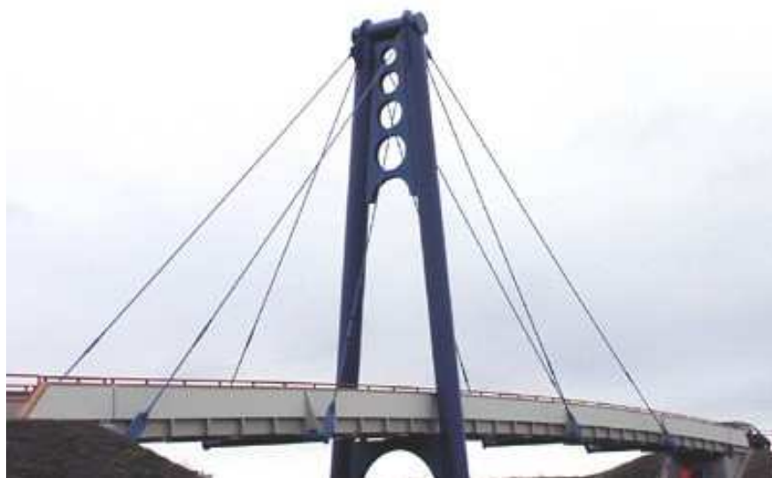
Rysunek 1.2: Most Schwerin-Neumühle (2003) - źródło: http://en.structurae.de
