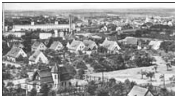
il. 8. Zachodnia część osiedla mieszkaniowego DWM. Ok. 1924-25. Karta pocztowa z lat 20. XX stulecia.
