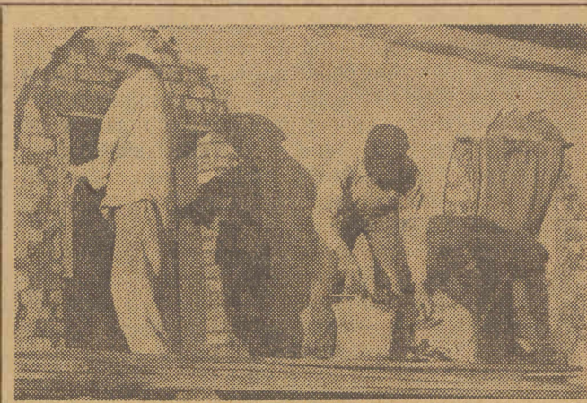
W Spółdzielni remontuje się zabudowania gospodarskie i domy mieszkalne. Nie będą już nigdy dzieci wójcińskie wychowywały się w wilgotnych, ponurych ruderach.
