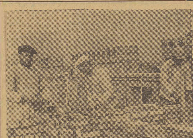
Fragmenty budowy „szybkościowca” w Osiedlu Robotniczym na Dębcu. U góry: robotnicy zatrudnieni przy pracach stolar-skich na wysokości 4 piętra. U dołu z lewej: zespół murarski Podeszwy, który przy budowie kominów na poddaszu osiągał przeciętnie 280 proc. normy. Z prawej: murarze wykańczają mury ostatniego piętra.
