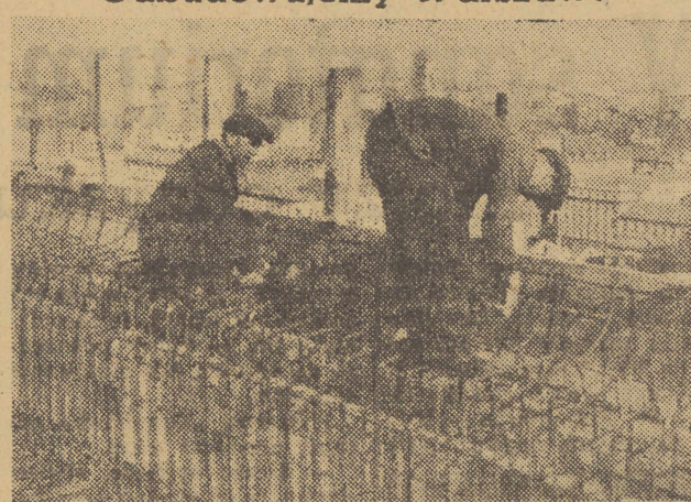
Najlepsi zbrojarze zatrudnieni przy budowie wieżowca, Stanisław Konarski i Feliks Mucha.
