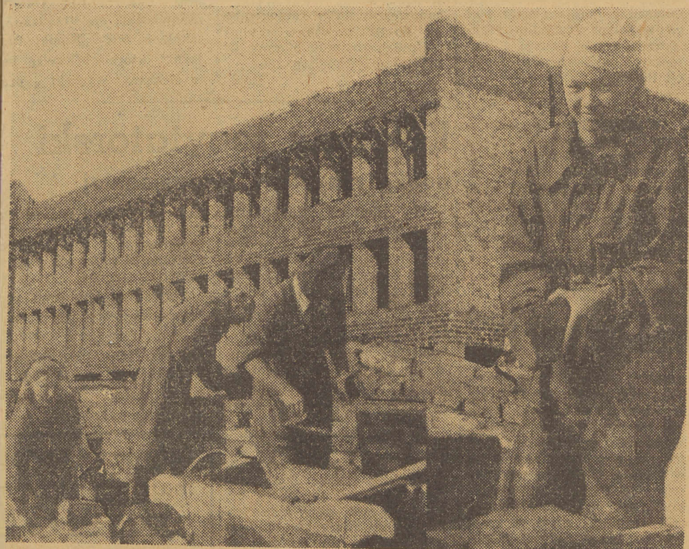
Przedsiębiorstwa budownictwa przemysłowego zaangażowały i wyszkoliły kilka kobiet w zawódzie murarskim. Pracują one obecnie przy wznoszeniu murów III piętra domu administracyjnego dla Poznańskich Zakładów Papierniczych na narożniku ul. Chudoby Ratajczaka w Poznaniu.
