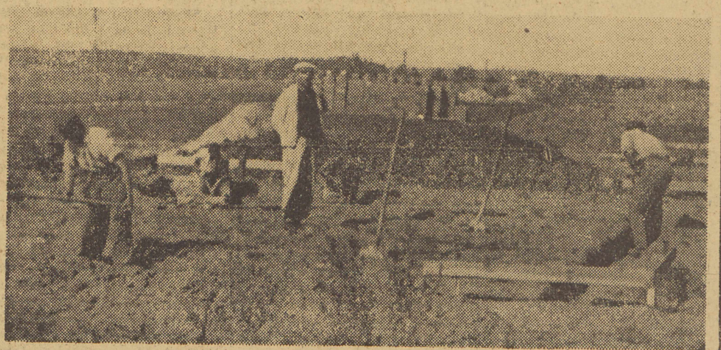
W Rolniczej Spółdzielni Wytwórczej w Wojnowie rozpoczęto budowę szeregu domków dla pracowników rolnych.
