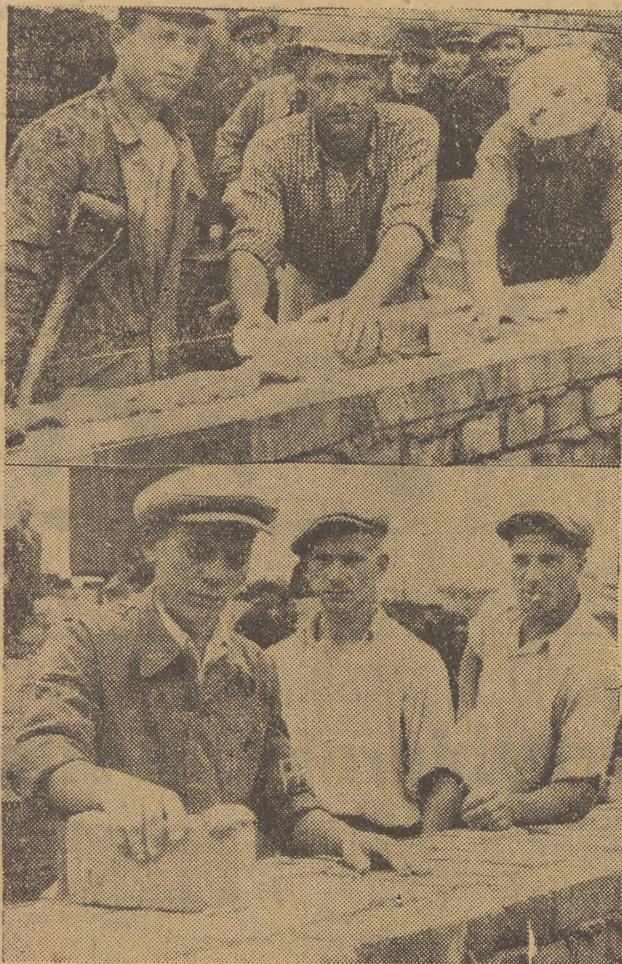
U góry trójka poznańska przy pracy. Od lewej ku prawej Jaskowiak, Pietrucha, Wesolek. Poniżej warszawianie: sprzedawca Franciszek Ptaszyński, Szlaga i Henryk Ptaszyński. Obok: Pietrucha kładzie cegły prosto do linii sznurka. Od właściwego ułożenia zależy wytrzymałość muru. (Do artykułu na str. 3).
