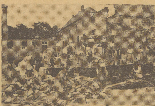
Szybko postępują prace przy odgruzowaniu Krosna nad Odrą. Dużo wysiłku w oczyszczaniu ulic włożyły kobiety, które obecnie uzyskały w tej akcji przodujące miejsce.
