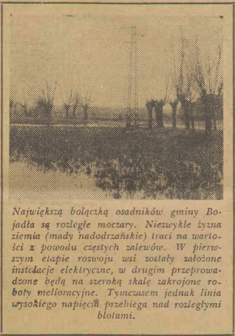
Największą bolączką osadników gminy Bojadła są rozległe moczary. Niezwykle żyzna ziemia (mady nadodrzańskie) traci na wartości z powodu częstych zalewów. W pierwszym etapie rozwoju wsi zostały założone instalacje elektryczne, w drugim przeprowadzone będą na szeroką skalę zakrojone roboty melioracyjne. Tymczasem jednak linia wysokiego napięcia przebiega nad rozległymi błotami.
