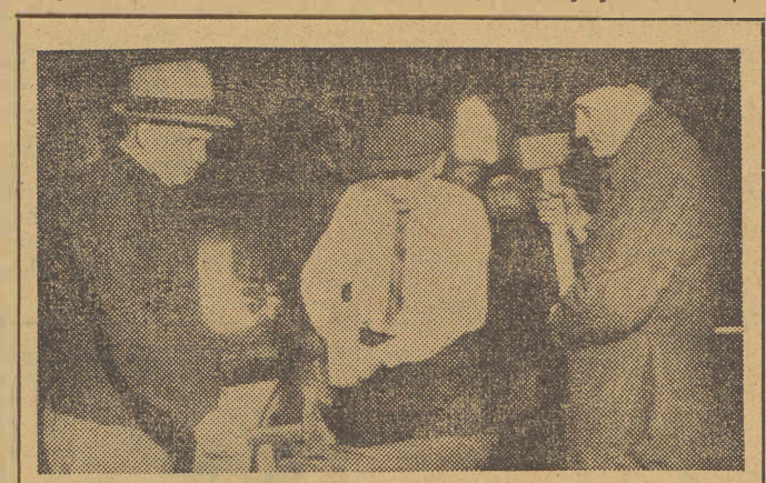
— Raz, dwa, trzy... Miarowo biją młody wykluwając lemiesz do pługa. Robotnicy „Wiepofany” Szeller, Pytlak i Skibiński pra-cują w pocie czoła w trzcielńskiej kuźni.
