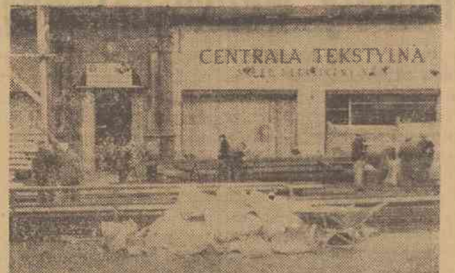
Praca nad odbudową dawnego hotelu „Bazar” trwa dniem i nocą. Na otwarcie Międzynarodowych Targów Poznańskich wszystko musi już być gotowe. Trzy zmiany po 200 robotników rozwijają prawdziwie „polskie tempo”.
