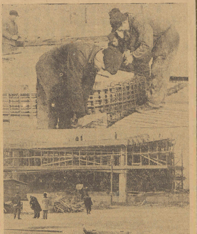
Na terenie Międzynarodowych Targów Poznańskich buduje się nowy wspaniały pawilon Min. Komunikacji. Roboty budowlane mają być ukończone do dnia 15 lutego. Od góry: grupa robotników wykonuje prace zbrojeniowe na dachu pawilonu. Poniżej: ogólny widok pawilonu, którego objętość wynosi 12,000 m 3 . Będzie to jeden z najpiękniejszych pawilonów na Międzynarodowych Targach Poznańskich.
