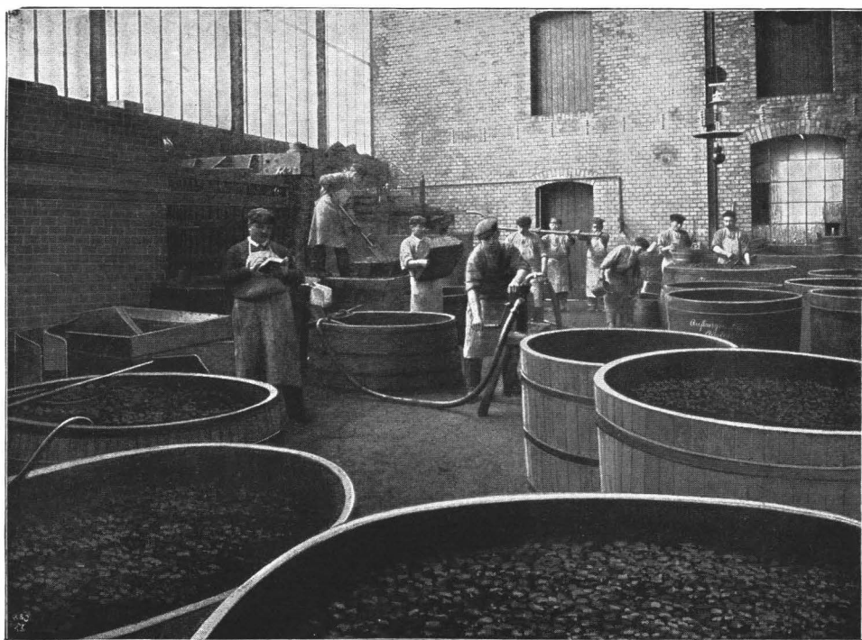
Abb. 192. Hydraulische Kelter (moderner Betrieb). (Zu Seite 188.)
