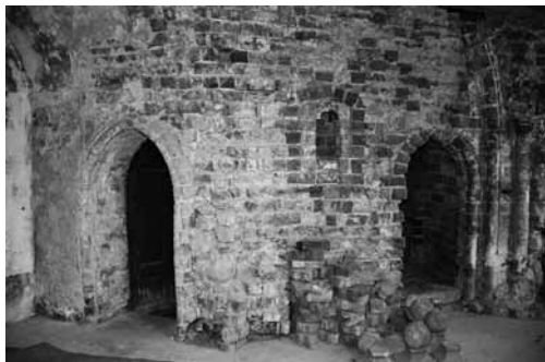
Relikty najpewniej dawnej zakrystii od strony północnej prezbiterium
