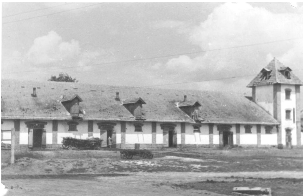
Lata 50. XX w. Tak wyglądała obora w majątku Leona Podleskiego od strony podwórka
