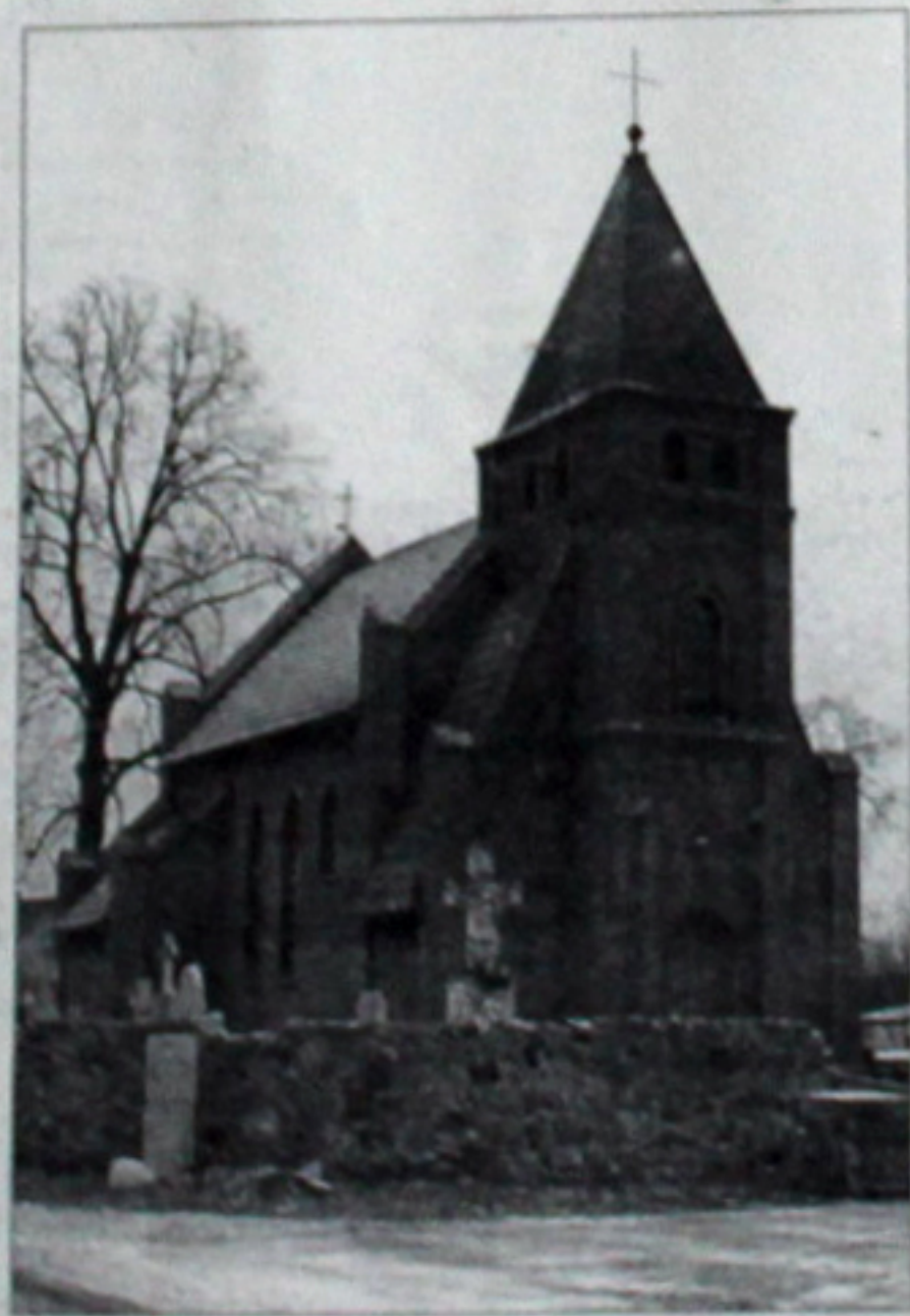
Kościół już odbudowano, ale trzeba go jeszcze wyposażać i zakupić sprzęt liturgiczny.
