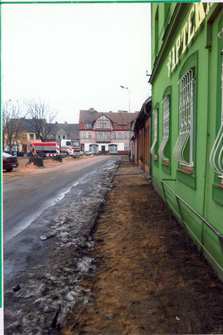
Przygotowanie podłoża pod kostkę betonową
