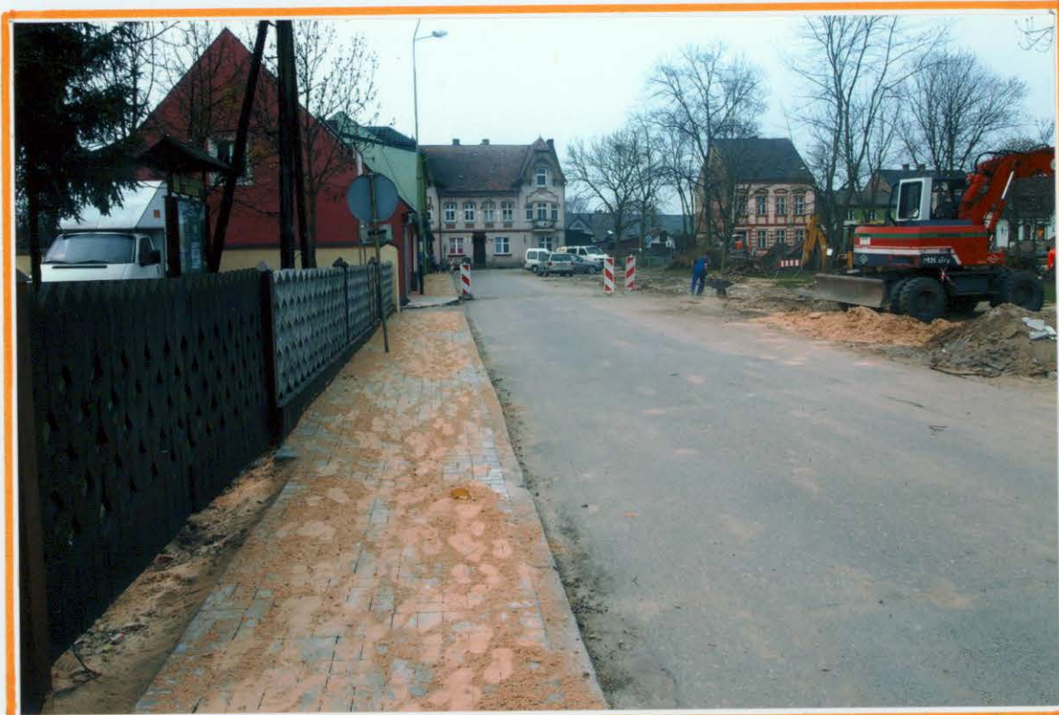
Prace wykończeniowe na chodniku od strony południowej
