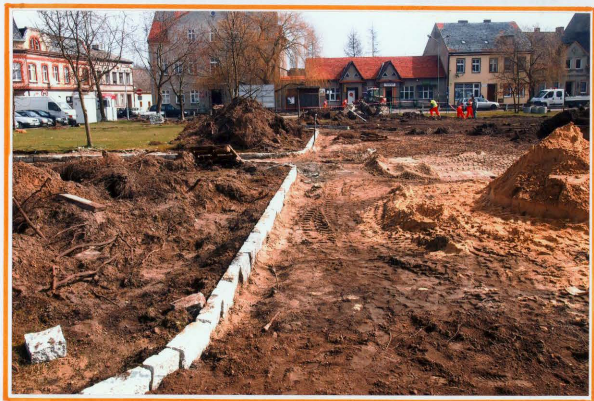
Montaż krawężników
