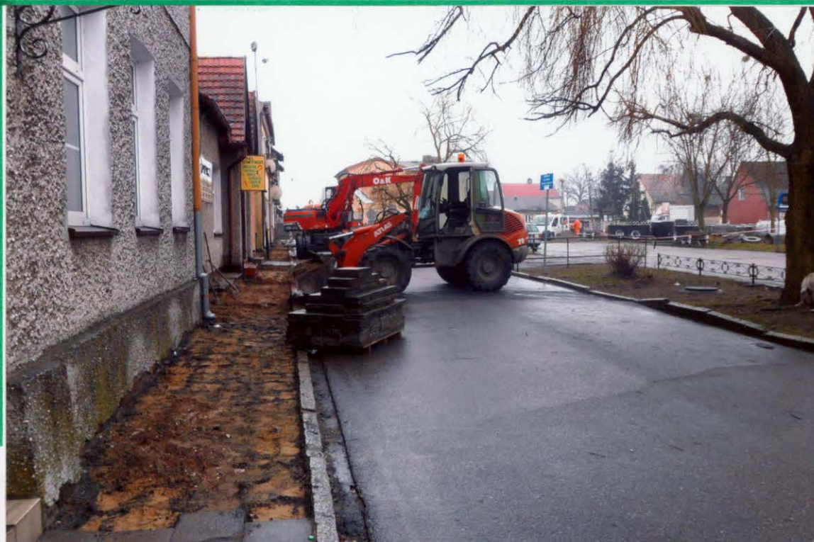
Układanie kostki betonowej na chodniku
