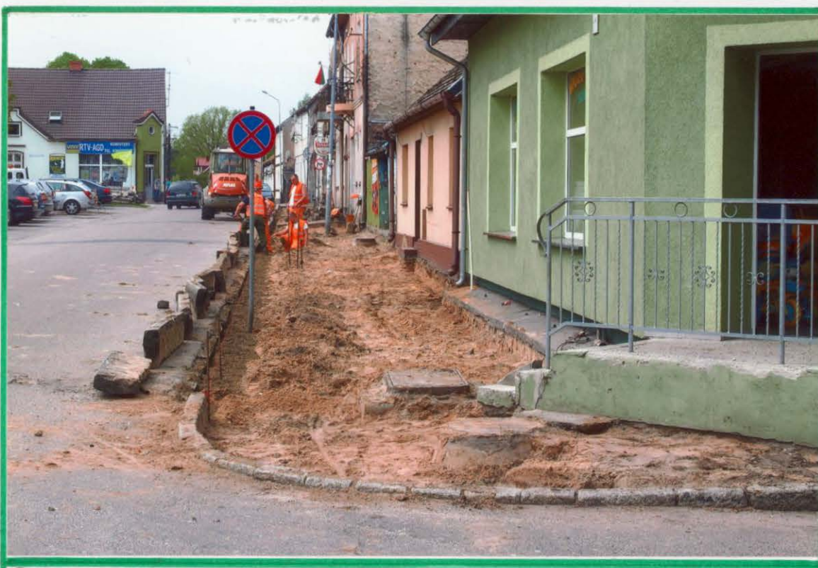
Przebudowa chodnika od strony północnej
