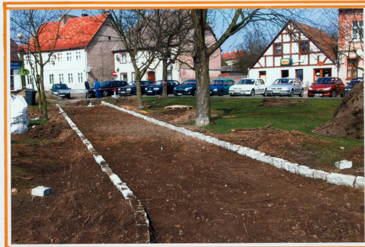
Montaż krawężników
