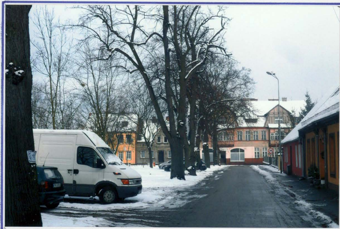
Przed remontem — od strony południowej
