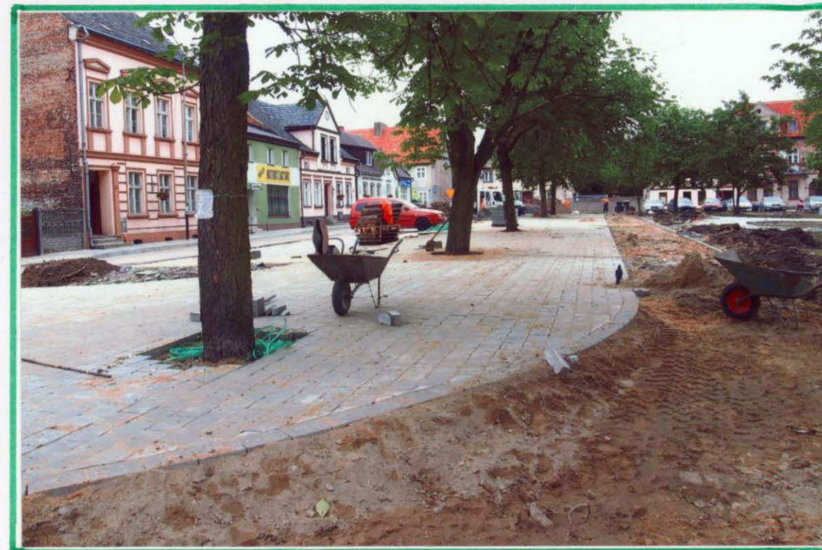
Prace wykończeniowe od strony wschodniej
