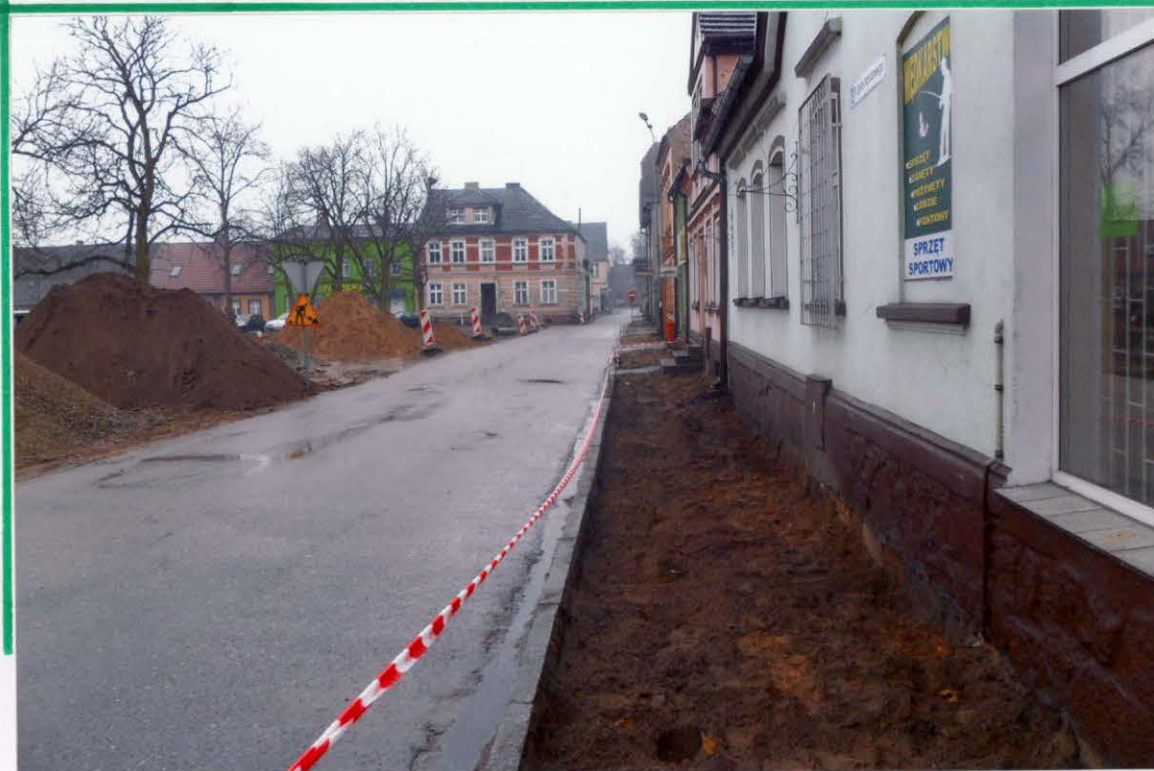
Prace przygotowawcze przed położeniem kostki betonowej - od strony zachodniej
