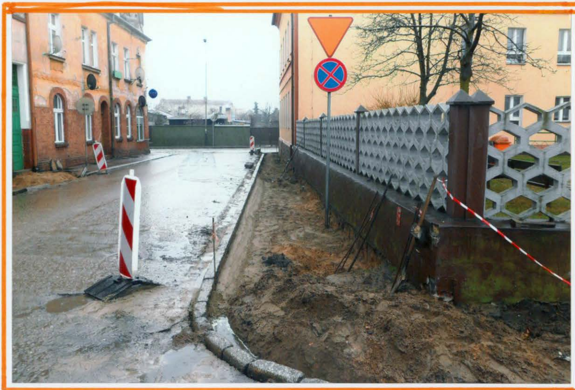
Montaż krawężników
