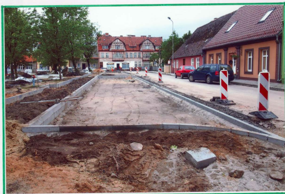
Miejsca parkingowe w budowie
