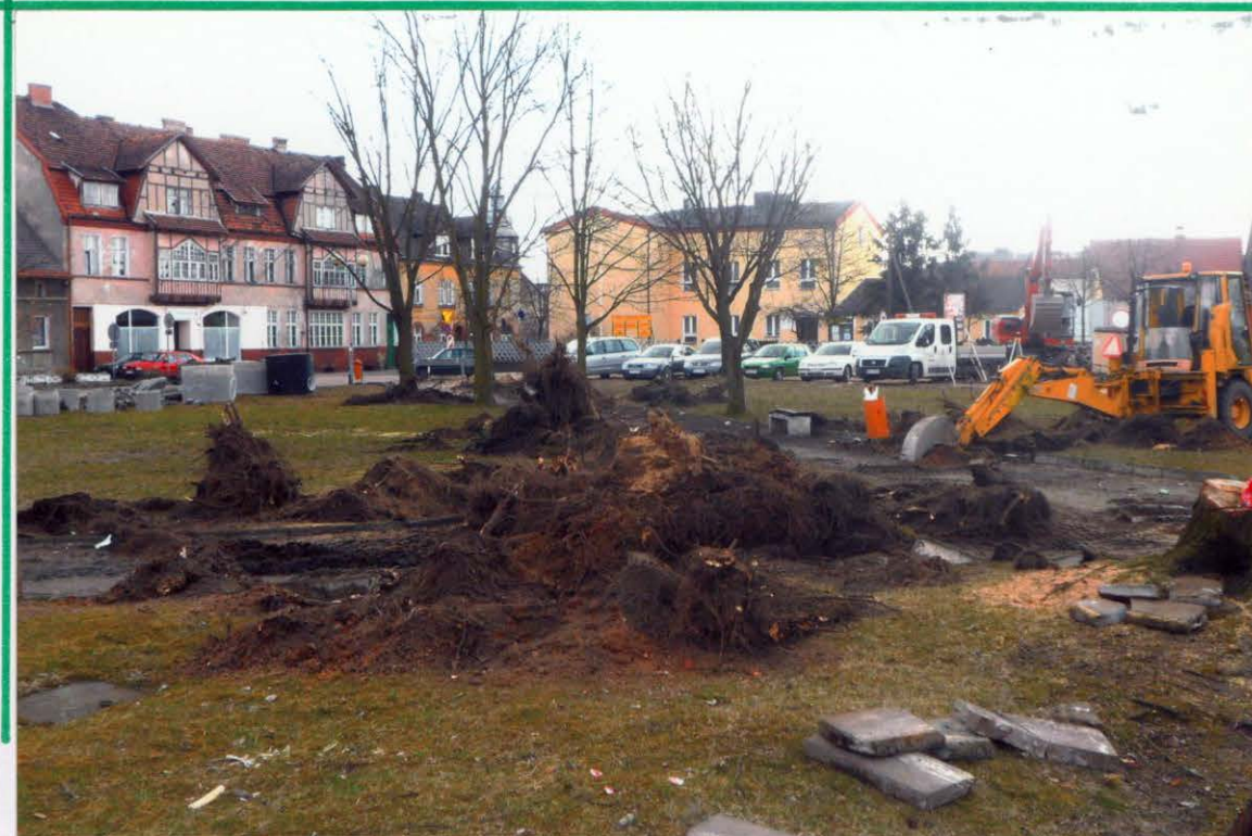
Prace ziemne na środku rynku
