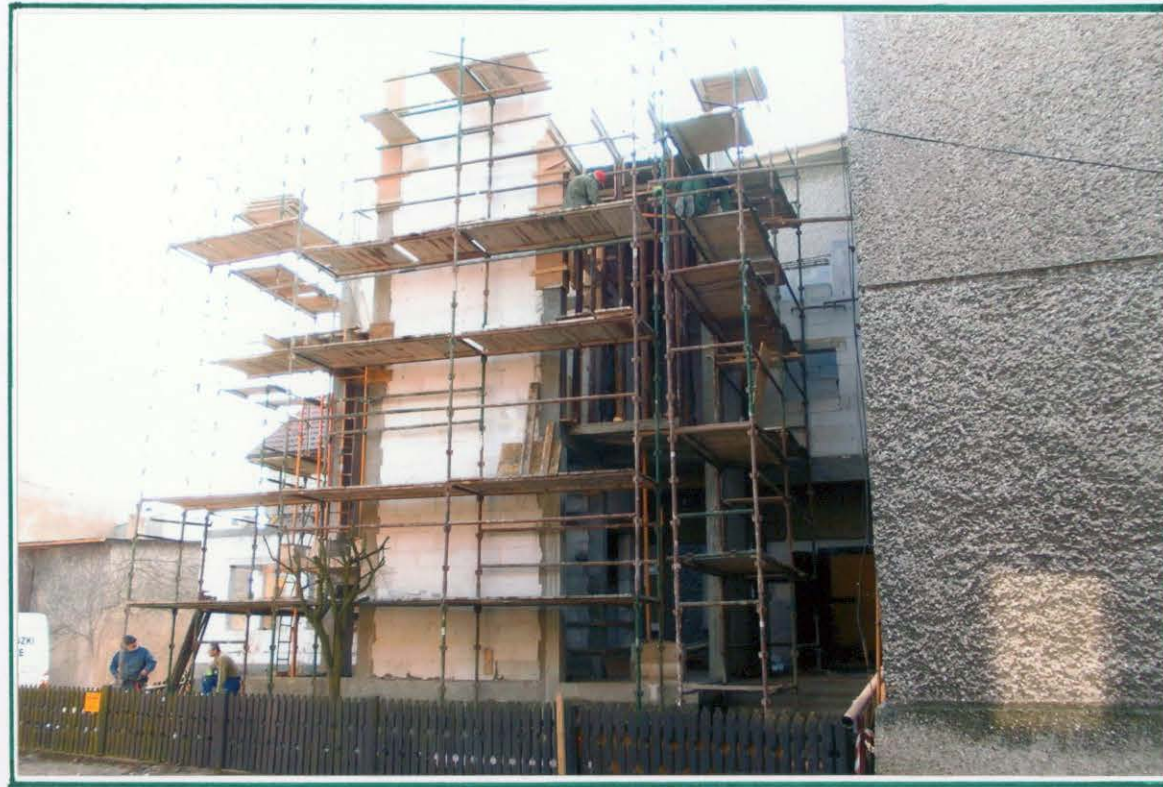
Widok na budowę od strony północnej...
