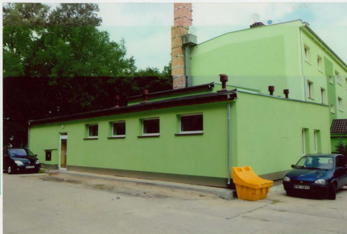
Budynek po remoncie
