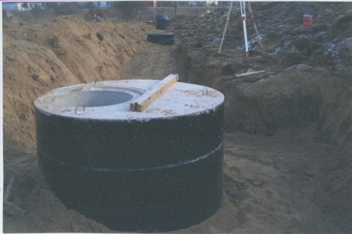
Budowa sieci kanalizacji sanitarnej
