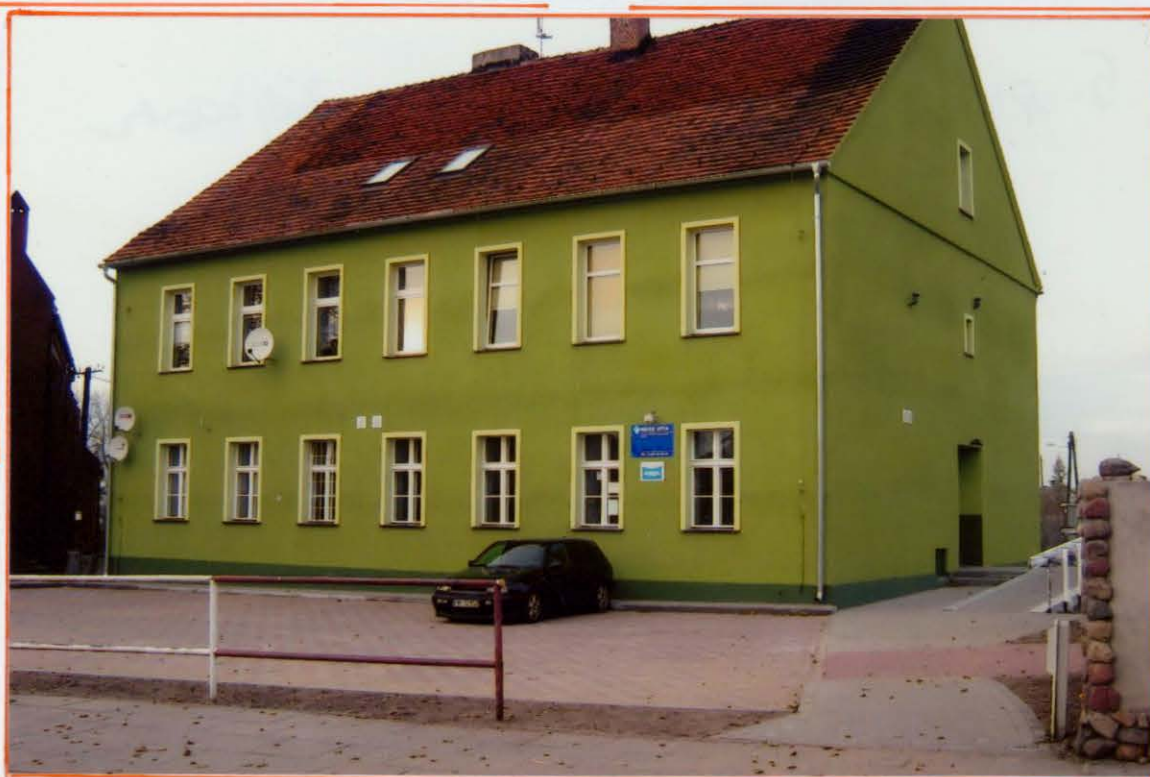
Utwardzony plac przy przychodni zdrowia
