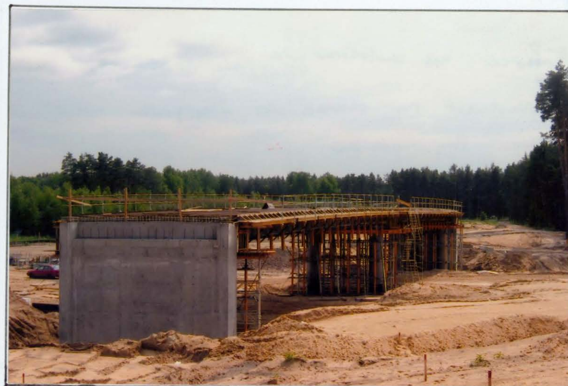
Wiadukt na drodze do Złogszynia przez Przychodźko
