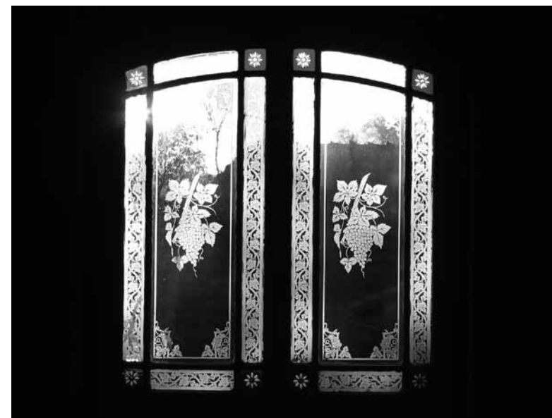
8. Okna kamienicy przy dzisiejszej ul. Bankowej 6. Fot. autora
