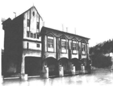
Elektrownia wodna w Bledzewie i elektryfikacja Ziemi Międzyrzeckiej 1906-1990
