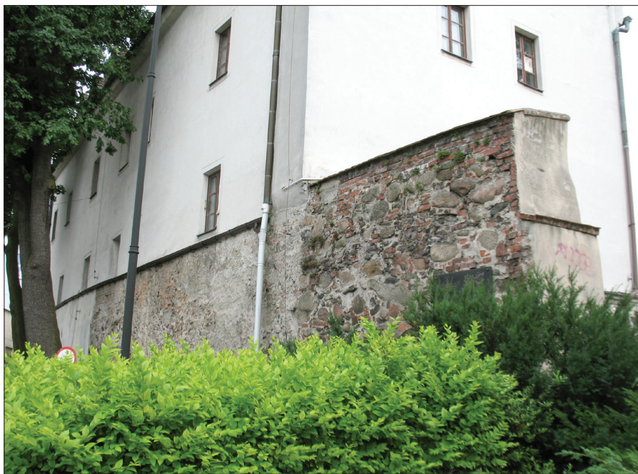
Ryc. 5. Zielona Góra. Północny odcinek murów obronnych. Stan obecny
