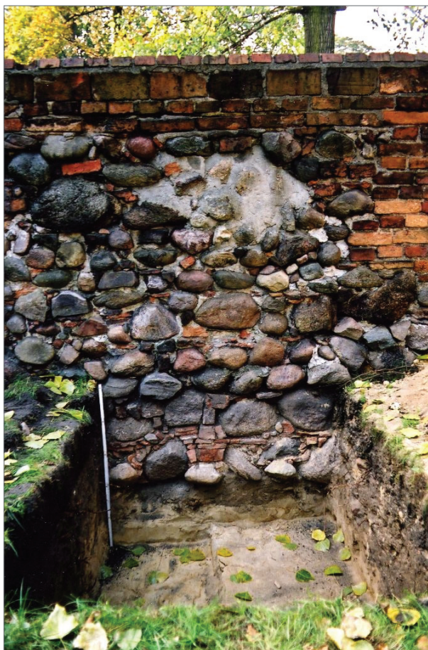
Fot. 1. Fragment muru tzw. cmentarnego przy ul. Podgórnej. Fot. K. Garbacz
