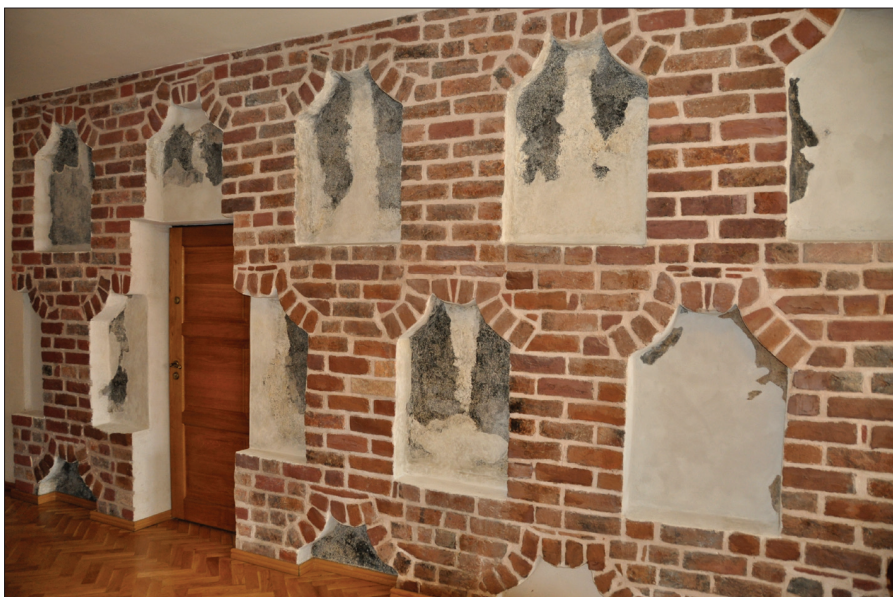
Ryc. 13. Zielona Góra. Ratusz, fragment pierwotnej ściany północnej. Widoczne kurtynowe płyciny zdobiące gotycką ścianę szczytową. Obecnie ściana wewnętrznej klatki schodowej
