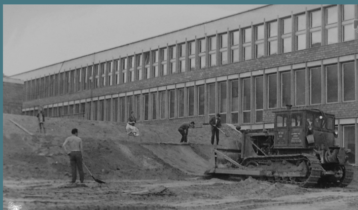
Plac budowy Wyższej Szkoły Inżynierskiej, 1965 r.
