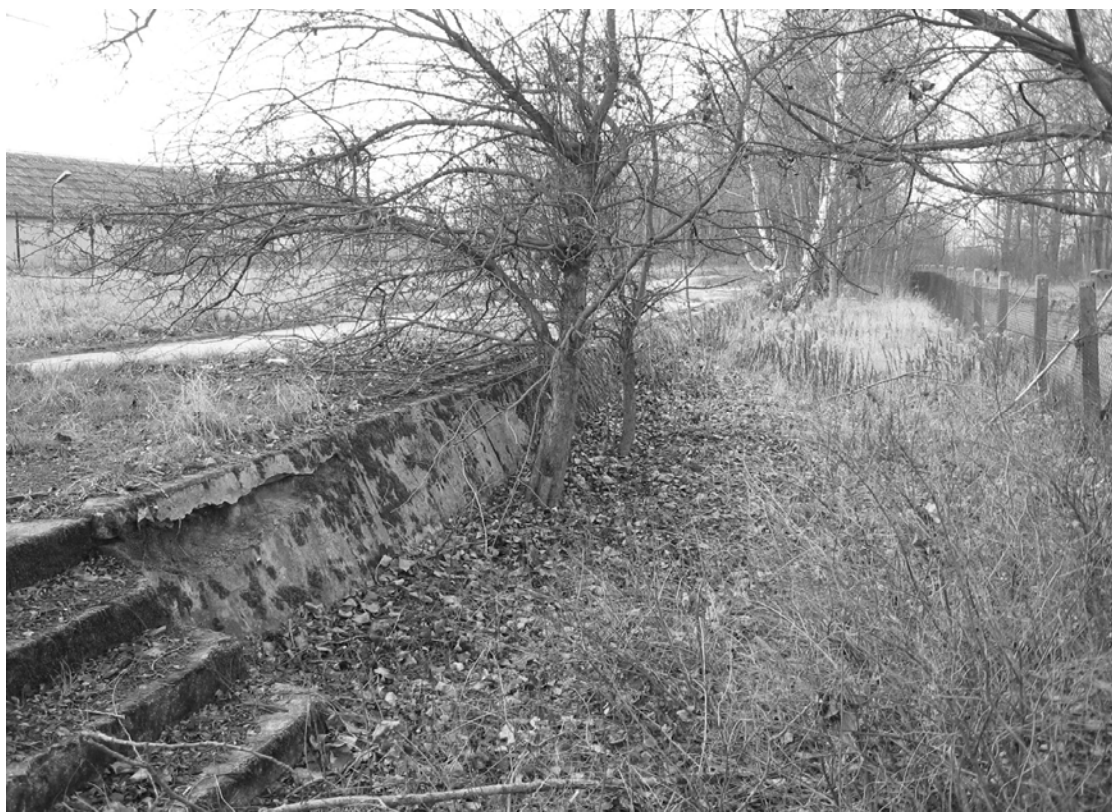
Kursko, rampa do rozładunku pancerzy fortecznych, nad którą operowały suwnice bramowe, fot. R. Michalak 2006
