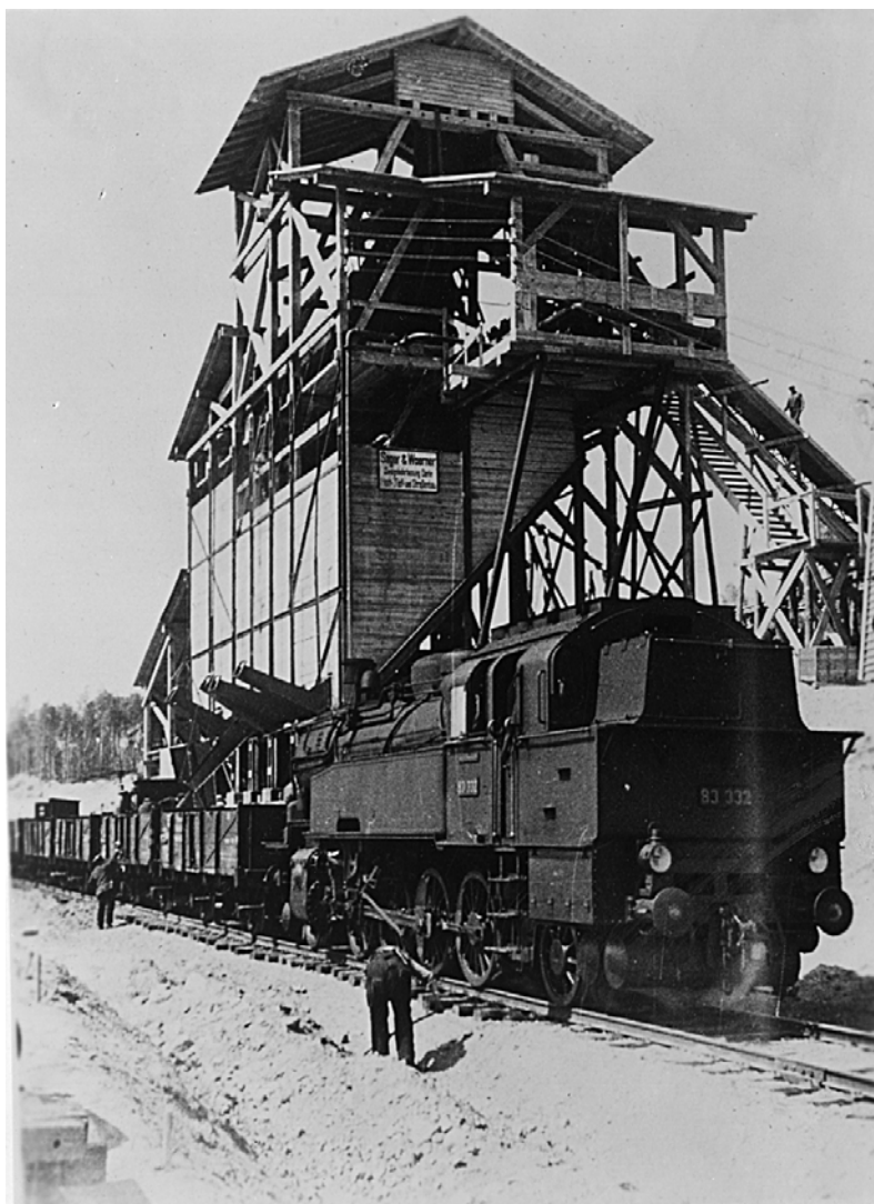
Przeładownia przy żwirowni koło Buczyny prowadzona przez firmę Sager & Woerner KG , na pierwszym planie widoczna pracująca na kolei budowlanej lokomotywa parowa serii 93 0-4 , źródło: Bayerisches Wirtschaftsarchiv, zespół akt: F 046 Sager & Woerner KG, München , sygn. F 046/467
