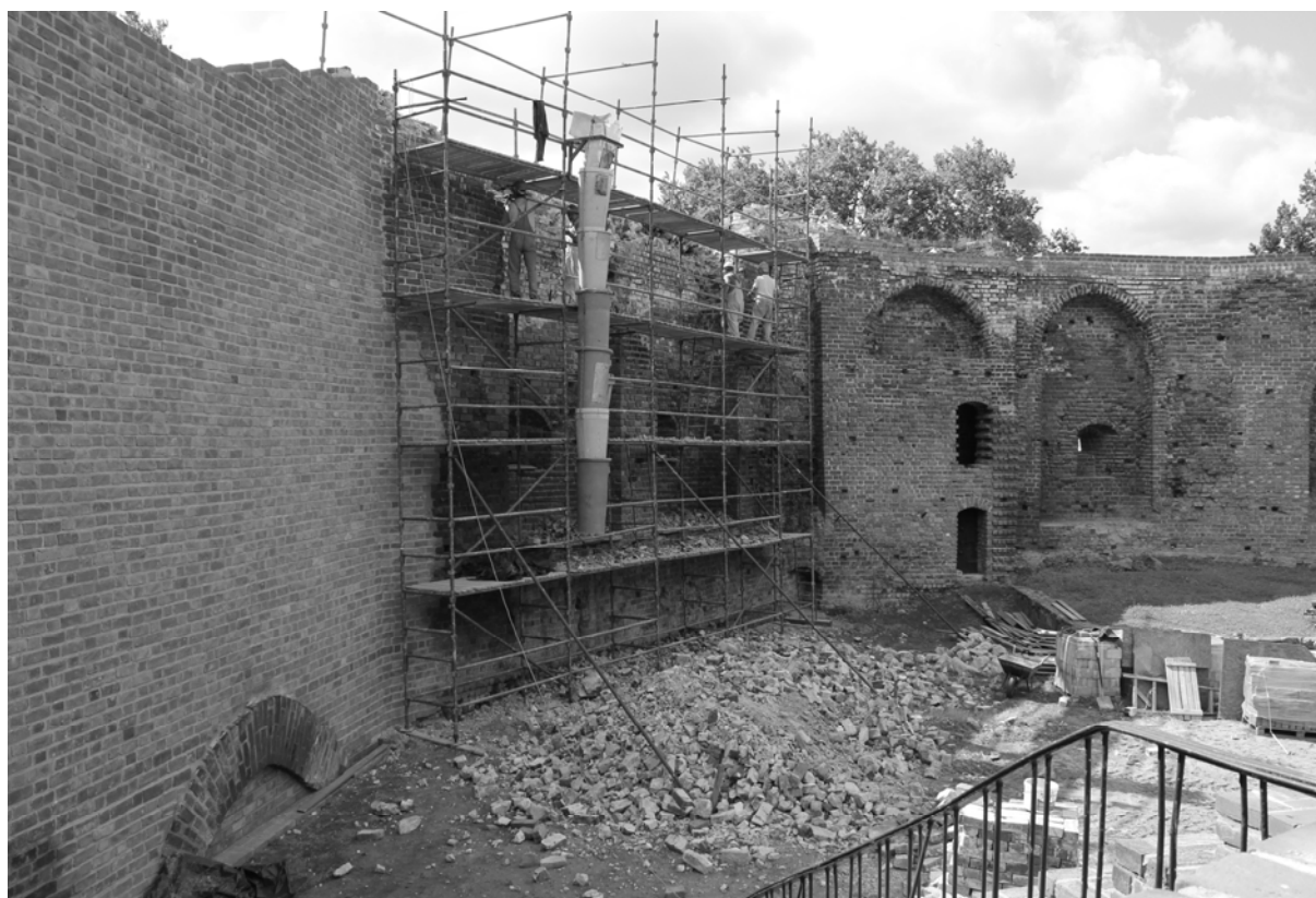
Fot. 5. Międzyrzecz, zamek - zewnętrzne lico muru obwodowego (część południowa); stan w trakcie wykonywania prac remontowo-konserwatorskich. Fot. Agnieszka Indycka
