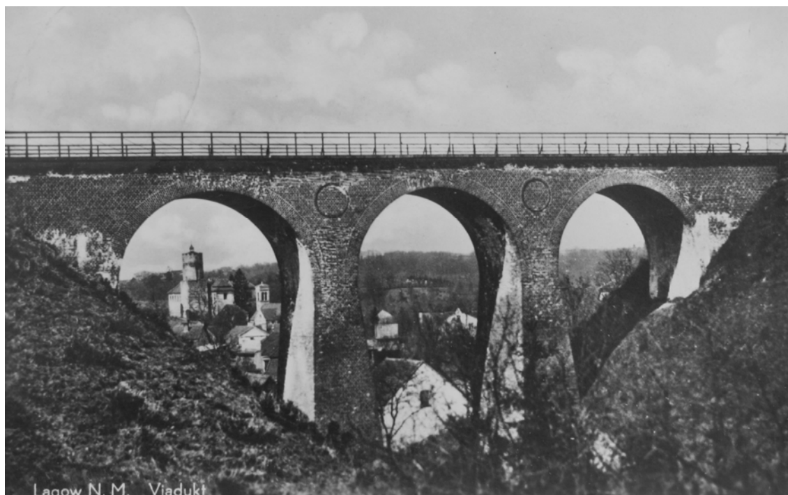
Ceglany wiadukt kolejowy w Łagowie był największą przeszkodą uniemożliwiającą transport najcięższych pancerzy do składu materiałów budowlanych przy stacji w Staropolu, (zbiory R. Michalak)
