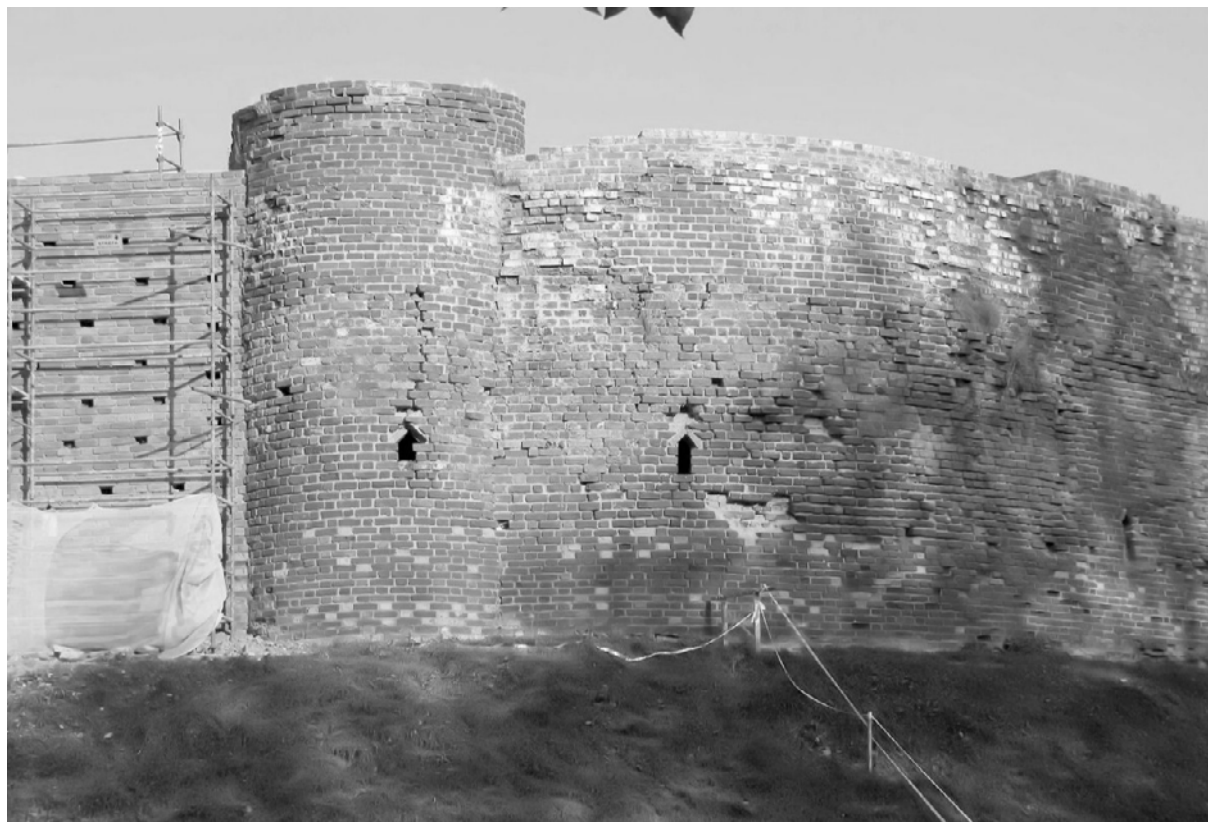
Fot. 3. Międzyrzecz, zamek - zewnętrzne lico muru obwodowego i wieży (część południowa); stan przed wykonaniem prac remontowo-konserwatorskich. Fot. Łukasz Bednaruk
