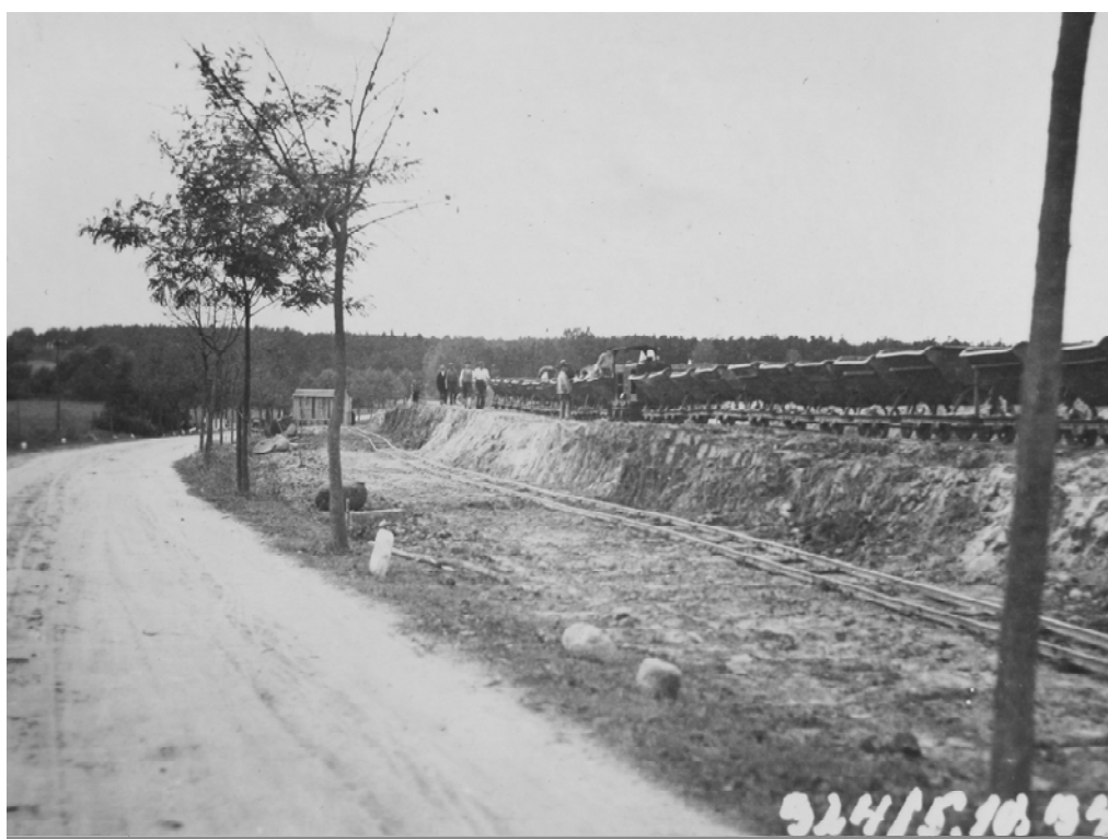
Wąskotorowa kolej budowlana 600 mm podczas budowy mostu K 611 i prowadzącej do niego drogi w październiku 1934 r., źródło: BA-MA, zespół akt: RH 32 Dienststellen und Einheiten der Festungspioniere , sygn. RH 32/2017
