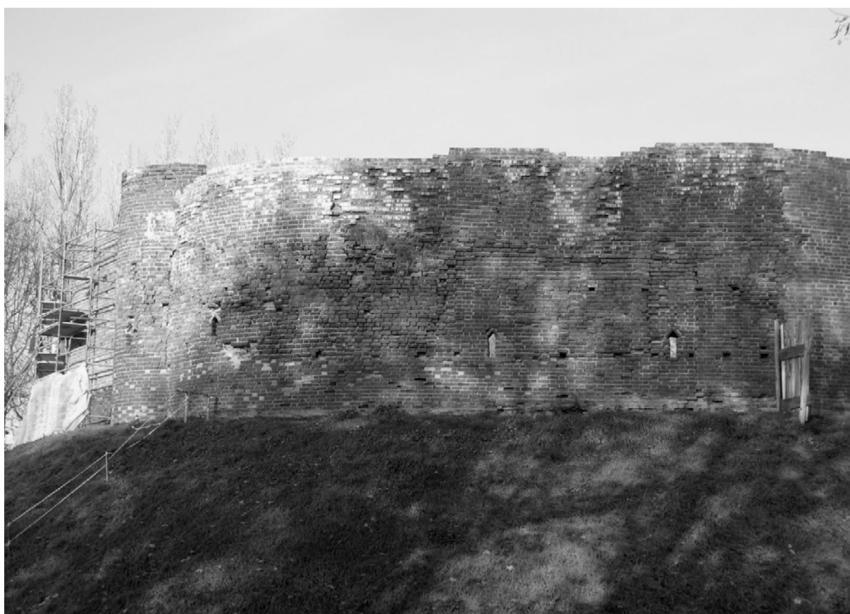
Fot. 2. Międzyrzecz, zamek - zewnętrzne lico muru obwodowego (część południowa); stan przed wykonaniem prac remontowo-konserwatorskich. Fot. Łukasz Bednaruk
