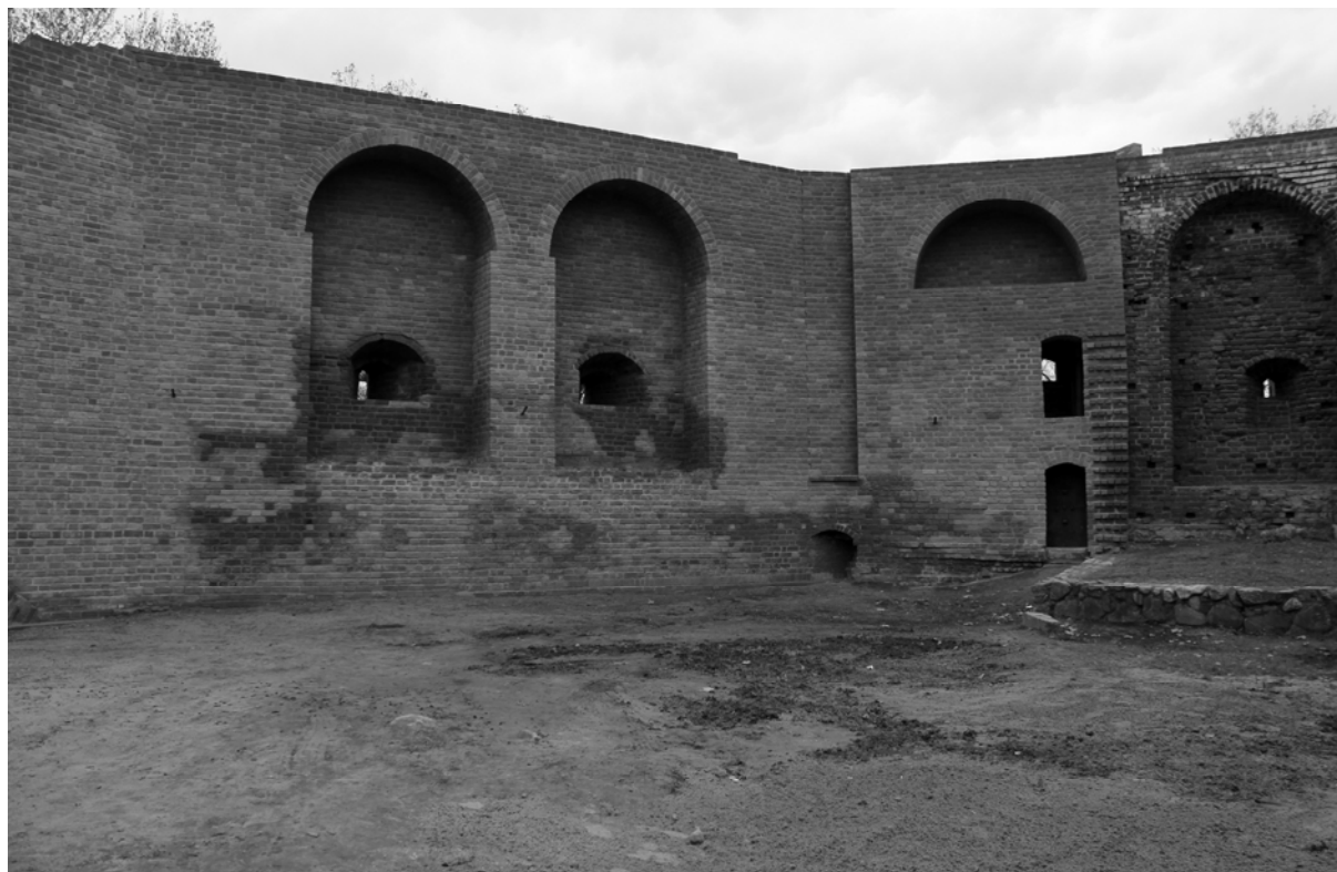
Fot. 7. Międzyrzecz, zamek - wewnętrzne lico muru obwodowego i wieży (część południowa); stan po wykonaniu prac remontowo-konserwatorskich. Fot. Agnieszka Indycka
