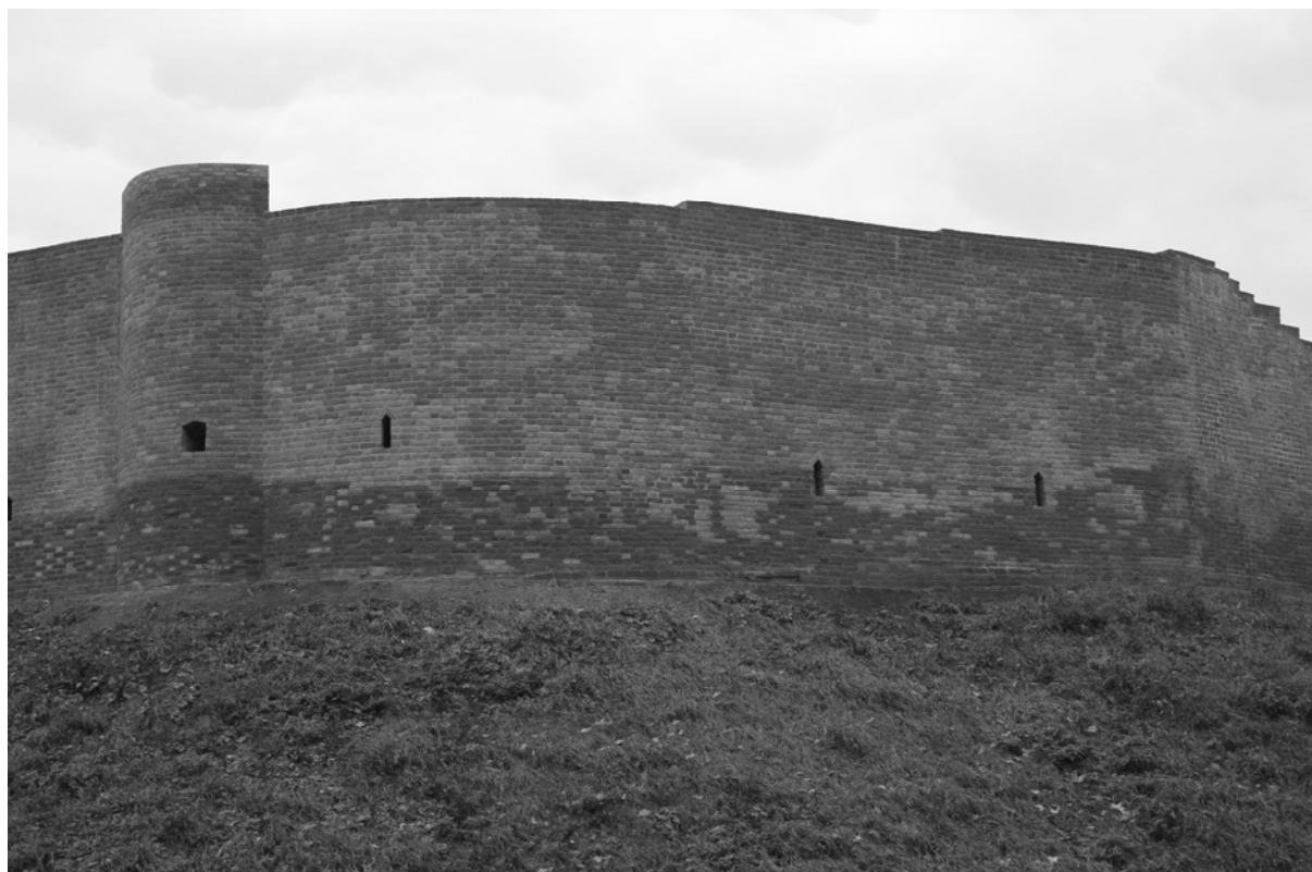
Fot. 6. Międzyrzecz, zamek - zewnętrzne lico muru obwodowego i wieży (część południowa); stan po wykonaniu prac remontowo-konserwatorskich. Fot. Agnieszka Indycka
