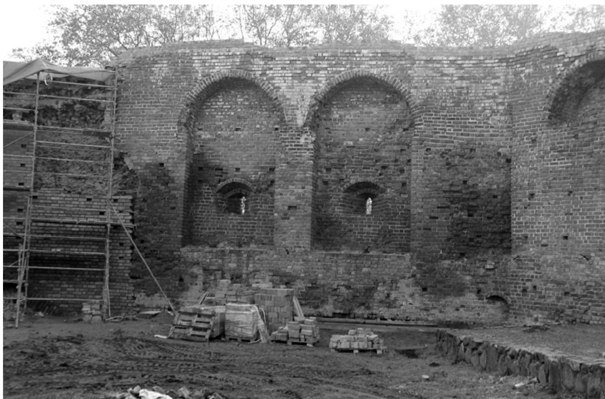
Fot. 4. Międzyrzecz, zamek - wewnętrzne lico muru obwodowego (część południowa); stan przed wykonaniem prac remontowo-konserwatorskich. Fot. Agnieszka Indycka
