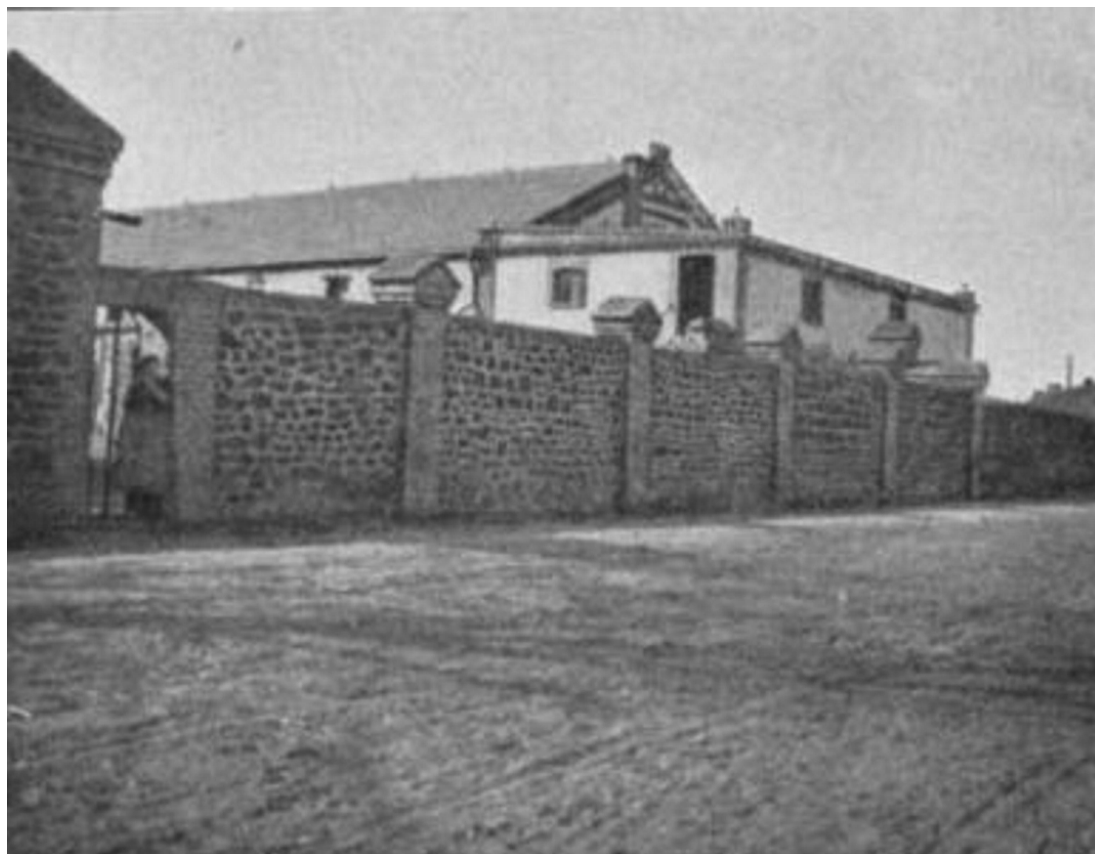
Fot. 1. Mur z rudy darniowej w Belęcinie (P. Hergermann, Die Gewinnung und Verwertung der Eisenerze in der Provinz Posen , Zeitschrift der Naturwissenschaft, Bd. 16, 1909 s. 65)
