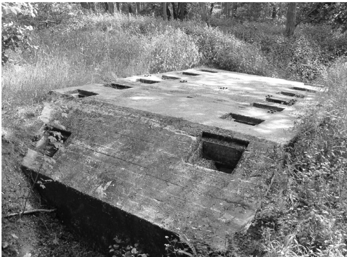
Zapora w nawierzchni linii kolejowej Międzyrzecz-Toporów, na wschód od Staropola, fot. R. Michalak 2010
