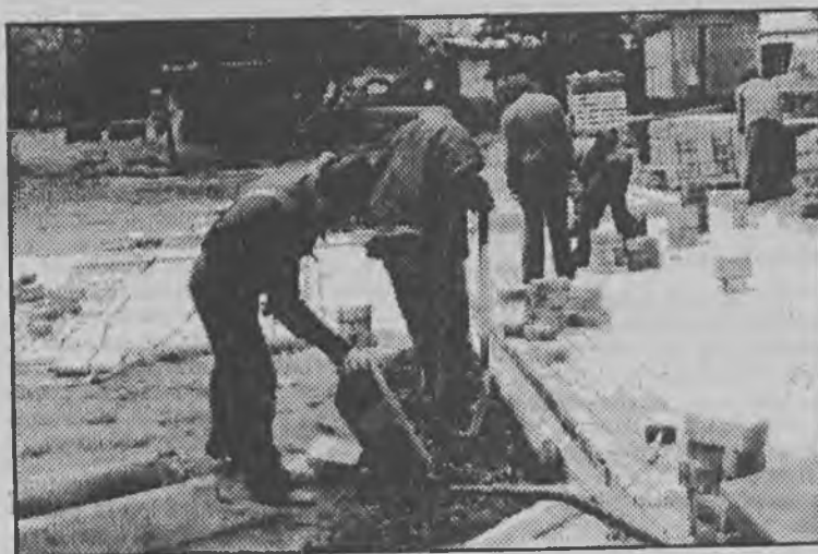
W Polkowicach trwa „chodnikowe szaleństwo”. Wymienia się większość trotuarów, zamiast tradycyjnych płyt kładąc zgrabną, kolorową kostkę. Metr kwadratowy takiego chodnika kosztuje 215 tys. zł. Fot. Albina Fila
