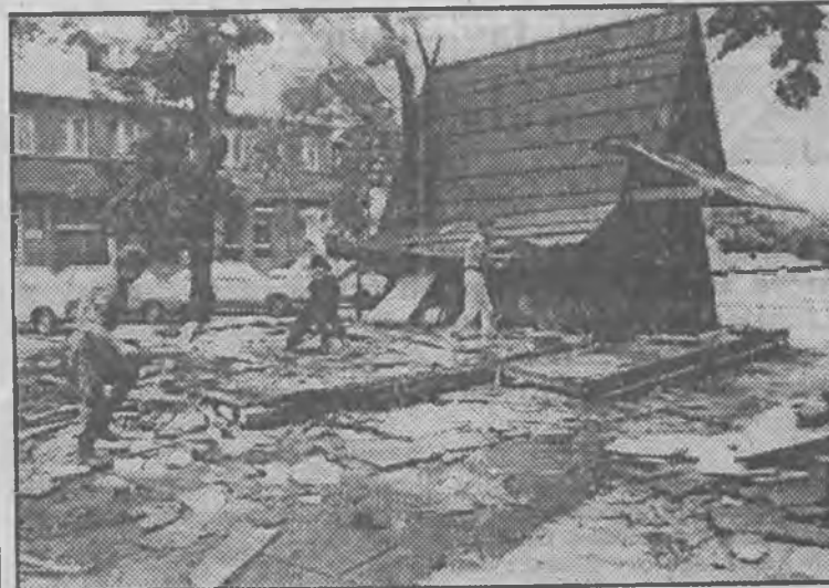
Trwa rozbiórka ostatnich pawilonów handlowych przy ul. Kasprówicza. Fot. Marek Woźniak
