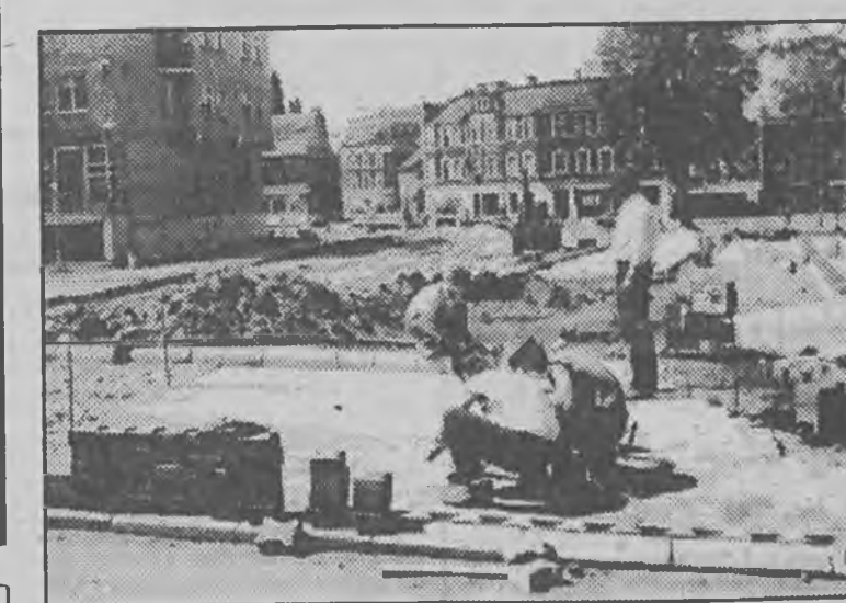
Przy ul. Chopina będzie nowy parking. Obecnie prowadzone są roboty ziemne, układana kostka. Zakończenie prac nastąpi 20 sierpnia.
