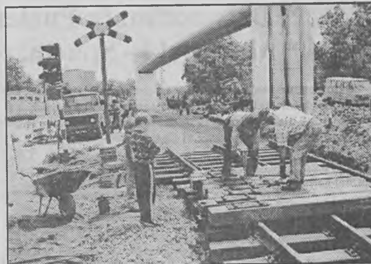
Barczo sprawnie przebiega remont torów na skrzyżowaniu ulic: Jaskółcza, Wiśniowa, 1 Maja i Moniuszki. Wygląda na to, że już wkrótce będzie można tędy przejeżdżać bez ograniczeń.
