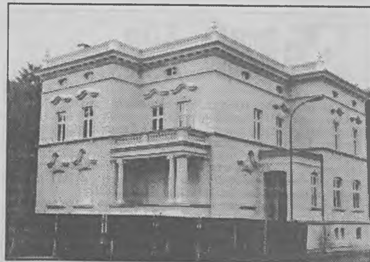
Dobiega końca remont kapitalny pięknego, starego budynku naprzeciwko DT „Centrum” w Zielonej Górze. Wkrótce zasiedli go Państwowy Zakład Ubezpieczeń.
