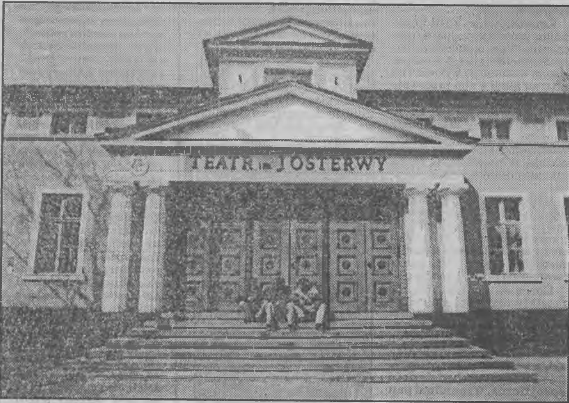
Wymieniliśmy poszycie dachowe i dachówki. Człowiek, który to robił wpadł przez sufit do sąsiedniego pomieszczenia. Fot. Marek Woźniak
