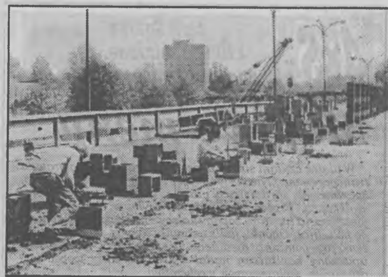
Przy ul. Wojska Polskiego buduje się 120 garaży. Samochody stojące do tej pory pod gołym niebem będą bezpieczniejsze.
