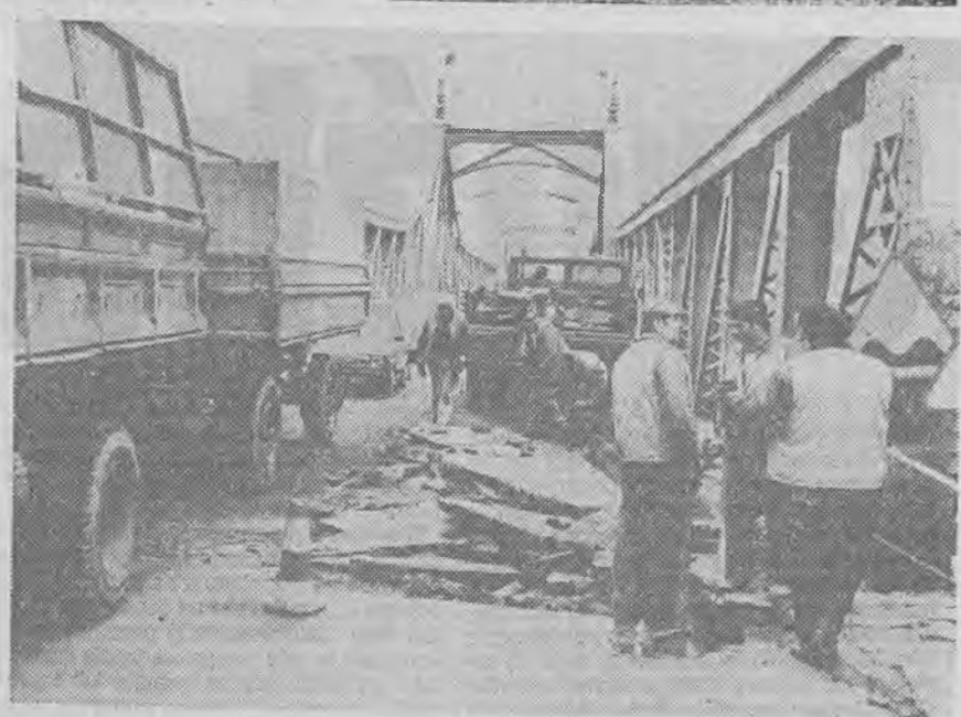
Most na Odrze w Krośnie Odrzańskim będzie miał nową nawierzchnię.
