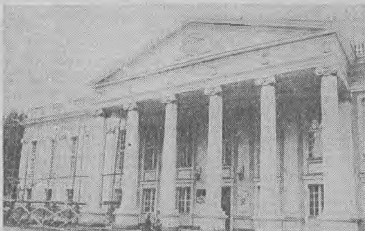
Trwa remont elewacji pałacowej Domu Turysty w Wolsztynie Fot. Marek Woźniak
