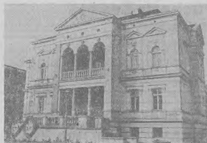
Nowa Sól. Budynek po byłym Komitecie Miejskim PZPR w coraz gorszym stanie. Ciągłe bez nowego właściciela.
