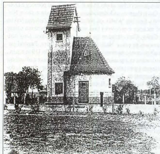
Stacja pomp przy ul. Botanicznej. 14 maja 1928 r.
