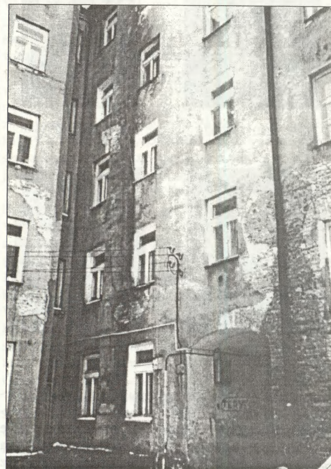
Warszawa, ul. Łucka Nr 16., m. 41. Dom mojego dzieciństwa. Wygląd „mojej kamienicy” w ostatnim okresie swojego istnienia! Okno z „mojego” mieszkania nr 41 znajduje się na trzecim piętrze jako trzecie licząc od strony prawej.
