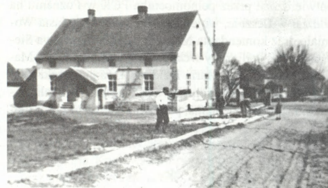
Budynek zdobyty na przedszkole w Nietkowie. Zostawiłam go odremontowany zmodernizowany i ogrodzony.
