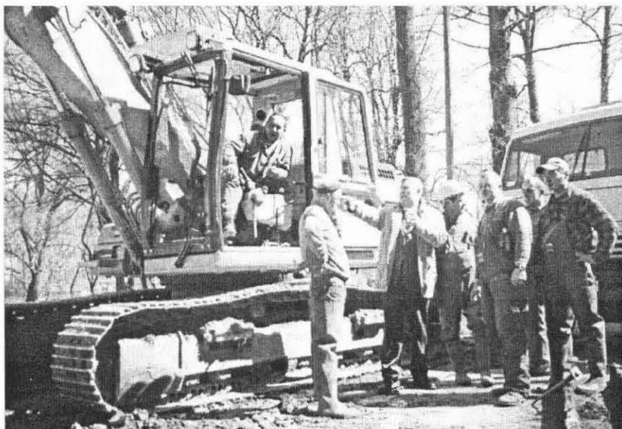
Burmistrz Tadeusz Dubicki (w środku) na placu budowy w rozmowie z pracownikami firmy „Niewiadomski”
