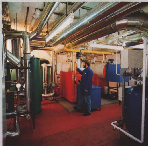
Nowoczesne kotłownie gazowe zastępują stare piece węglowe
