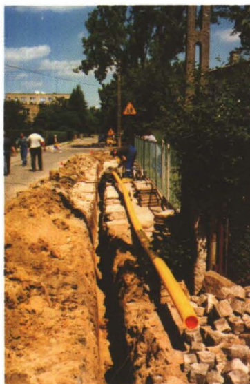
Budowa sieci miejskiej w Międzyrzeczu przez firmę EROWA Polska
