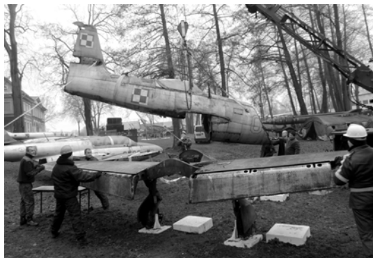
Żołnierze z 31 Bazy Lotnictwa Taktycznego w Krzesinach podczas demontażu Jak-a 23 w celu przeprowadzenia remontu w Poznaniu (fot. J. Sobociński)
