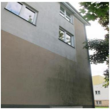
Phot. 1. View of the north-west facade of the building of the Institute of Environmental Engineering at the University of Zielona Góra, covered with the biofilm [Lechów 2014] Fot. 1. Widok na zachodnio-północną elewację budynku Instytutu Inżynierii Środowiska Uniwersytetu Zielonogórskiego z nalotem biologicznym [Lechów 2014]
