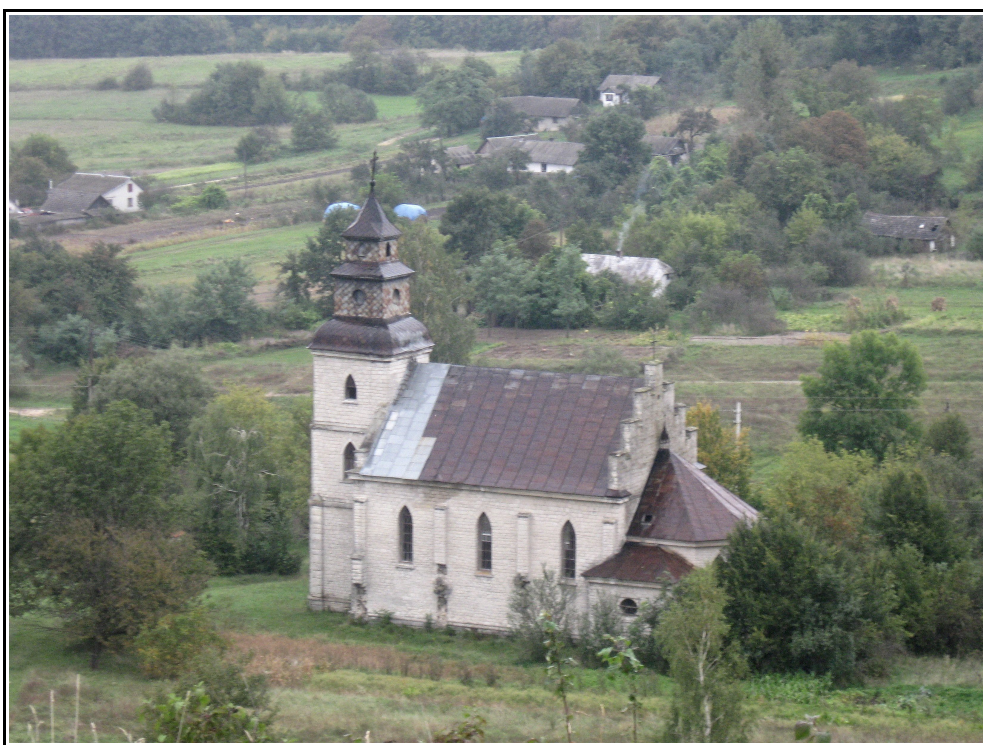
Kościół na Kozakach (fot. 2010 r.)
