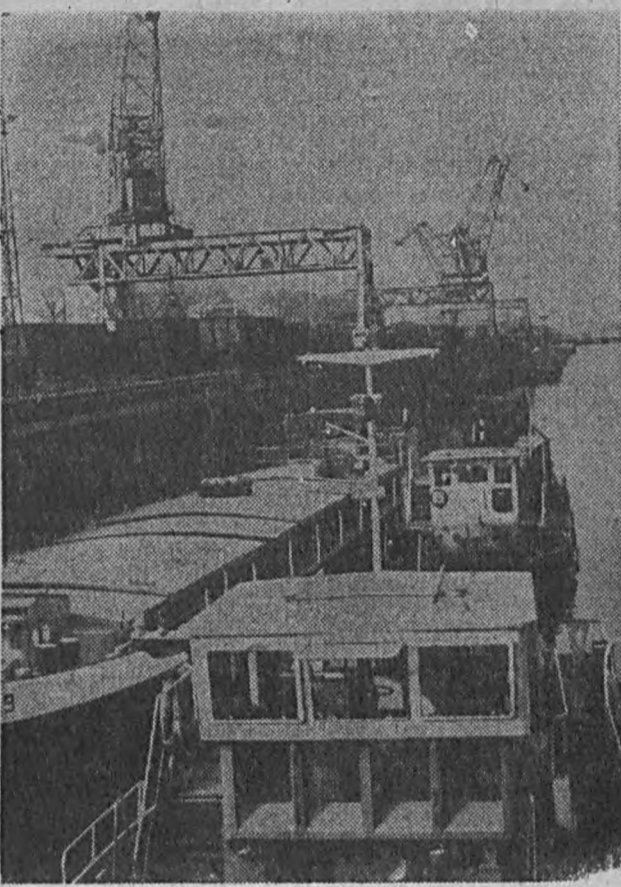
„Zeguga na Odrze” przewoziła w ciągu dziesięciu miesięcy br. około 8 mln ton towarów, głównie żelaza, rudy, kruszywa. Na zdjęciu: port w Koźlu. CAF
