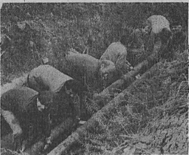
Mechanicy przy montowaniu rurociągu, który już pod koniec miesiąca ma połączyć dwa wydziały hutnicze. Fot. B. Bugiel
