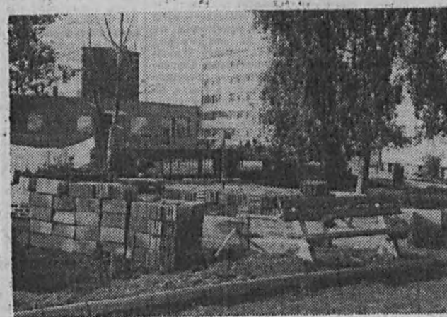
Budowa garaży przy ulicy Podgórnej. Ten płaski budynek to przedszkole nr 15.
