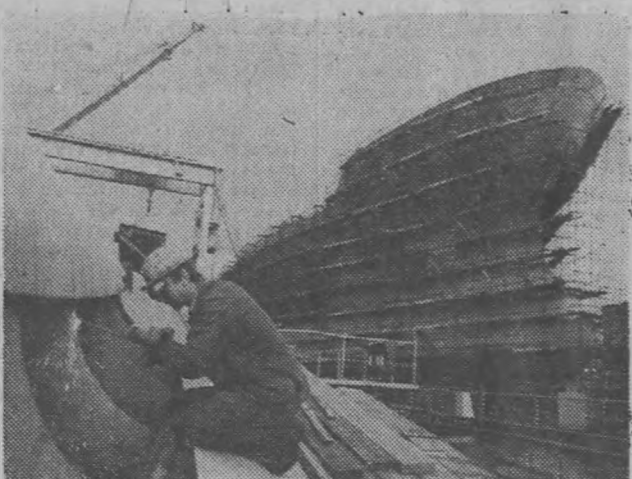
Na pochylu Szczecińskiej Stacji im. A. Warskiego znajdują się specjalistyczne jednostki — do obsługi gazociągów, naftociągów, promy pasażerskie, samochodowe i inne. W tym roku stacja przekeże jeszcze armatorem 14 jednostek.
