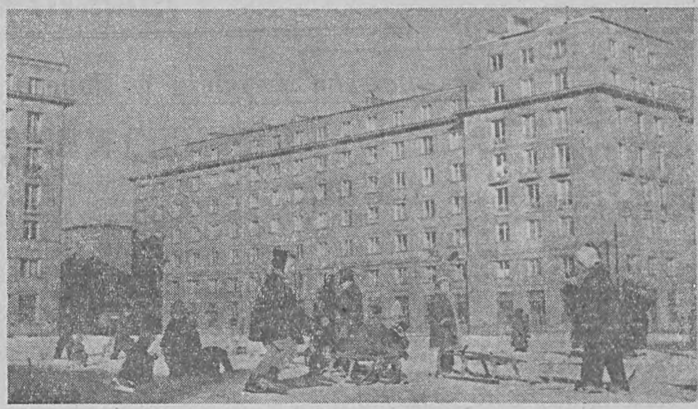
Zalóg Zjednoczenia Budownictwa Miejskiego Warszawa 7, w roku 1954 oddały ogółem na osiedlach Praga II i Grochowie — 3.352 izby mieszkalne. Rozbudowa osiedla Praga II trwa. W roku bieżącym przy budowie zostaną użyte elementy wielopłytowe. Na zdjęciu: Fragment osiedla Praga II.
