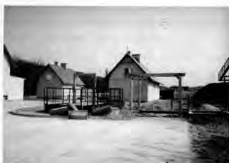
Budowa oczyszczalni – 1996 r.
