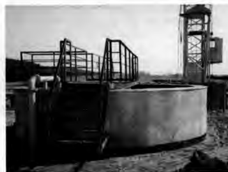
Budowa oczyszczalni w Pszczewie – 1996 r.
