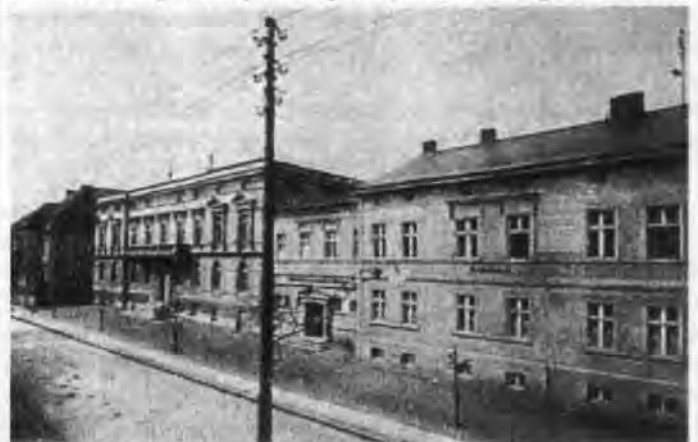
Kompleks budynków: Rady Powiatowej, Urzędu Powiatowego i Banku Powiatowego w Międzyrzeczu do 1945 r.
