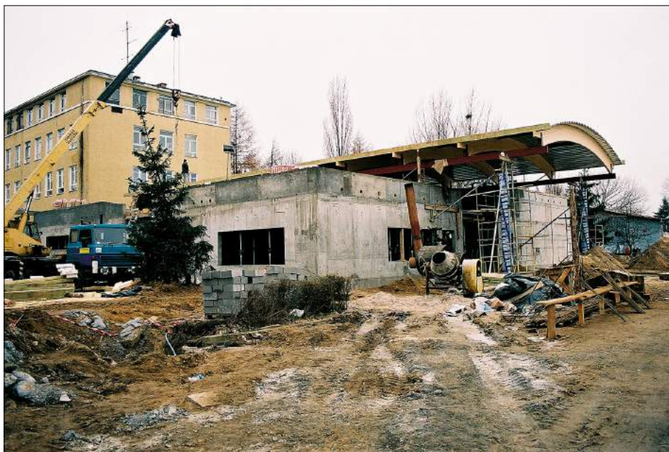
Fot. 13. Budowa Zakładu Radioterapii, 2004 r.
